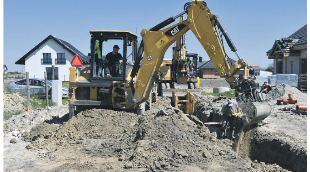
Trwają prace w Smardzowie
