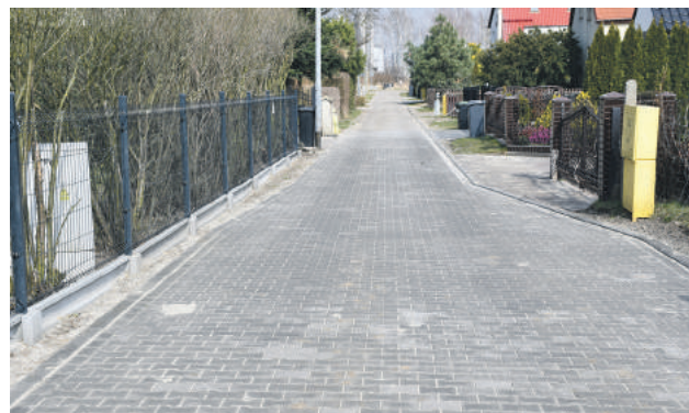
Ulica Konwaliowa w Bystrem po przebudowie
