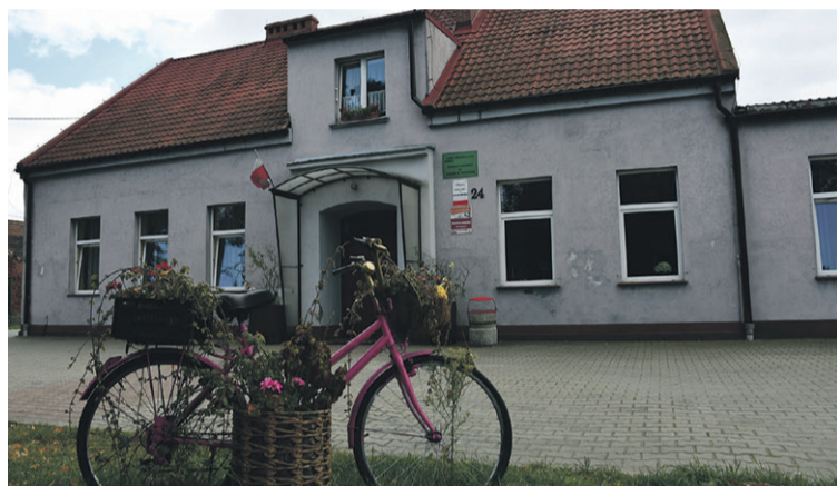
Trwają prace termomodernizacyjne w Ligocie Wielkiej
