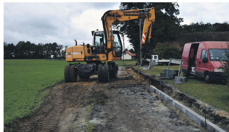
...przy okazji przebudowy drogi zaprojektowano także kanalizację deszczową
