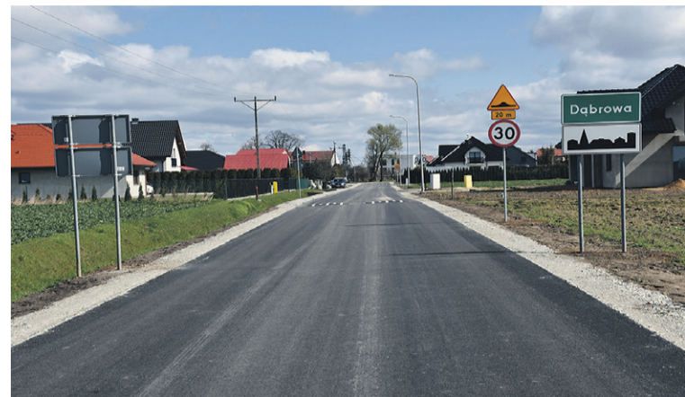
Budowa chodnika w Dąbrowie poprawi bezpieczeństwo pieszych
