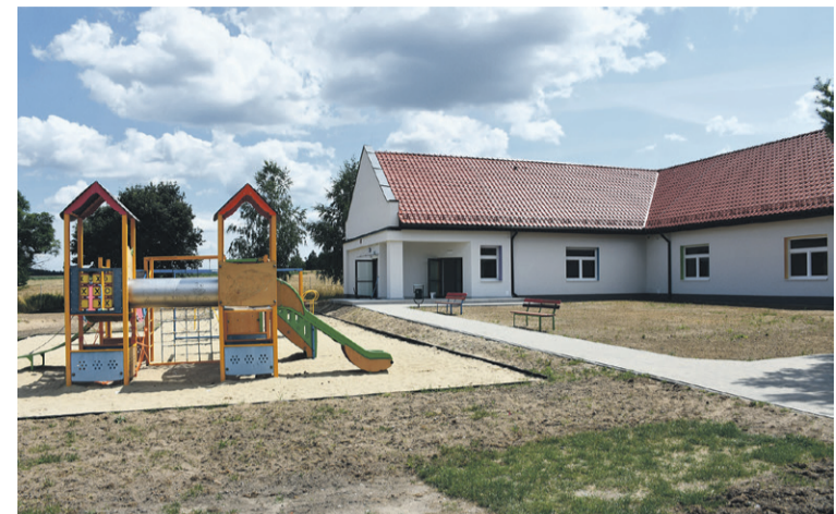
Inwestycja obejmowała dobudowę dwóch skrzydeł do istniejącego budynku
