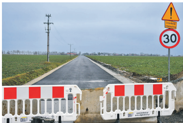
Dobiega końca remont drogi gminnej w Dąbrowie. Będą na niej wykonane wyspowe progi spowalniające
